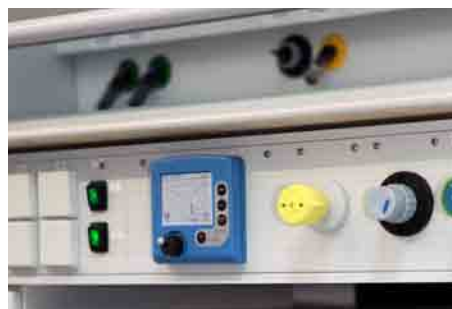
VACUU-LAN® - сеть с контроллером CVC 3000E для управления вакуумной сетью. Компактная интеграция в лабораторную мебель.
